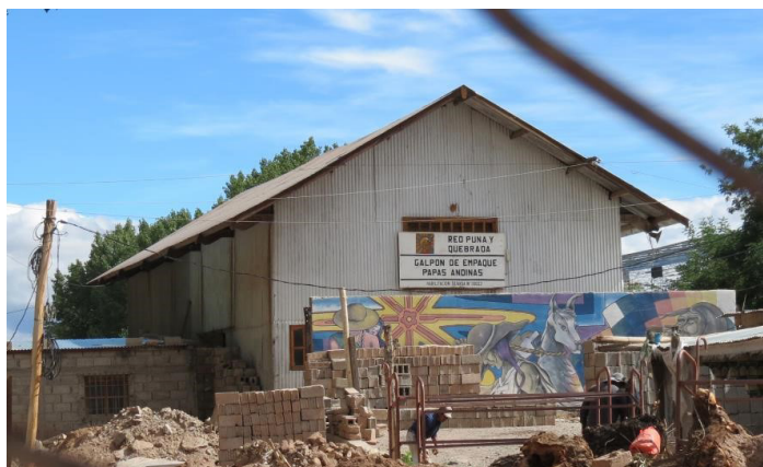
Figura 13. Galpón ferroviario. Estación Humahuaca
